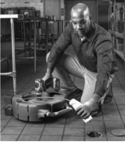
Şekil 13 – Kablo Kılıfına Yağlama Maddesi Uygulama
