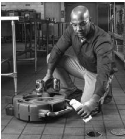
Figura 13 – Ungerea manșonului cablului
