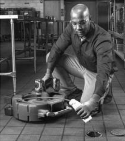
Figur 13 - Påføring av smøremiddel på kabelmantelen
