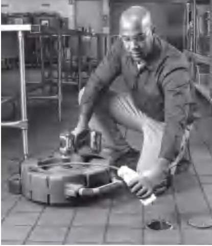
図 13 – ケーブルシースへの潤滑油の塗布
