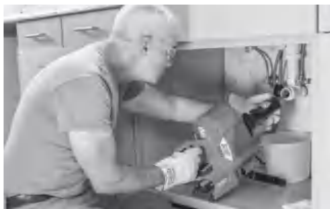
Εικόνα 13 – Πρωώθηση του σπιράλ με τη μονάδα AUTOFEED
