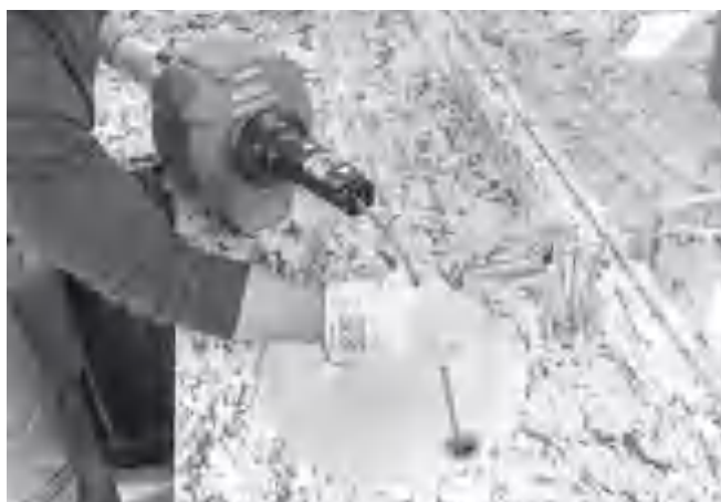
Obrázek 14 – Ruční posouvání kabelu
