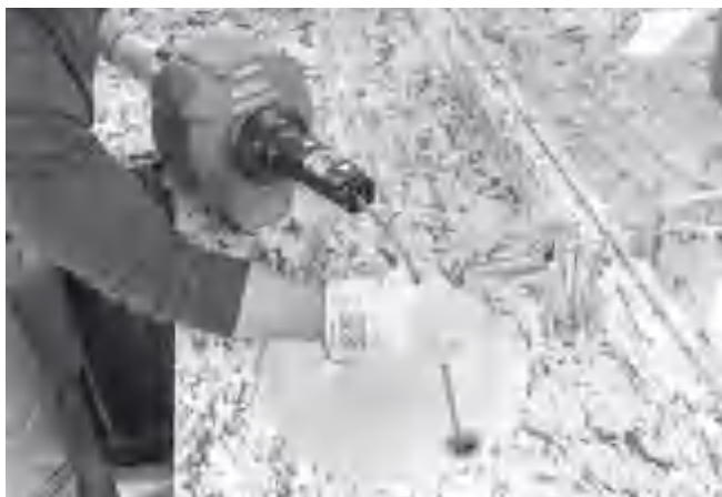
Rysunek 14 – Ręczne podawanie sprężyny
