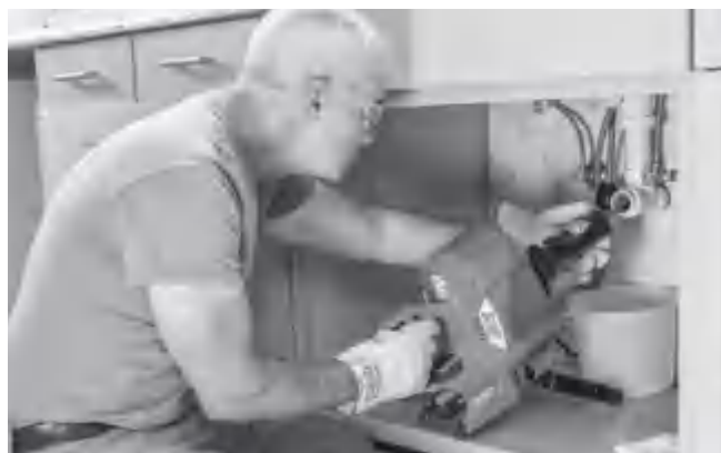
Figur 13 – Fremføring af spiral med AUTOFEED-enheden
