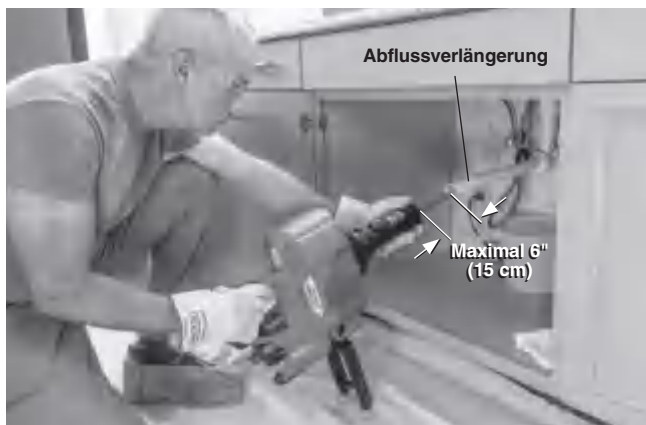
Abbildung 6 – Beispiel für eine Verlängerung des Abflusses auf weniger als 6" (15 cm) vom AUTOFEED Spirale vorschub
