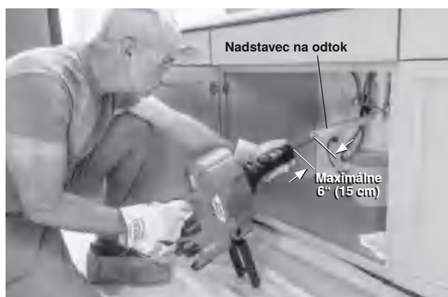
Obrázok 6 – Príklad rozšírenia odtoku do vzdialenosti 6" (15 cm) od jednotky autoposuvu AUTOFEED
