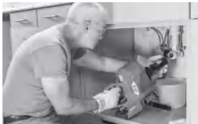
Figur 13 – Mating av kabel med AUTOFEED-enhet
