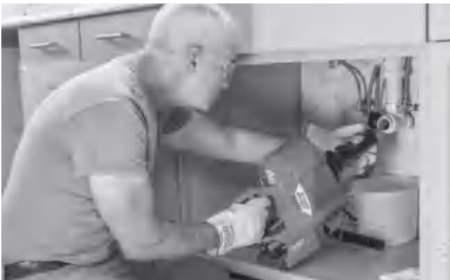
Figura 13 – Alimentación del cable con la unidad AUTOFEED
