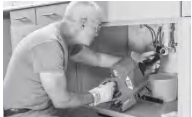
Kuva 13 - Jousen syöttäminen AUTOFEED-yksiköllä
