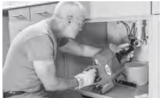
Afbeelding 13 – De veer met de AUTOFEED-eenheid invoeren
