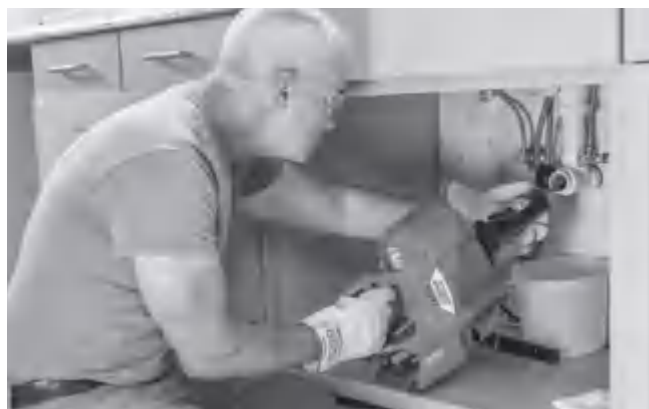
図 13 – AUTOFEED ユニットでのケーブルの送り出し
