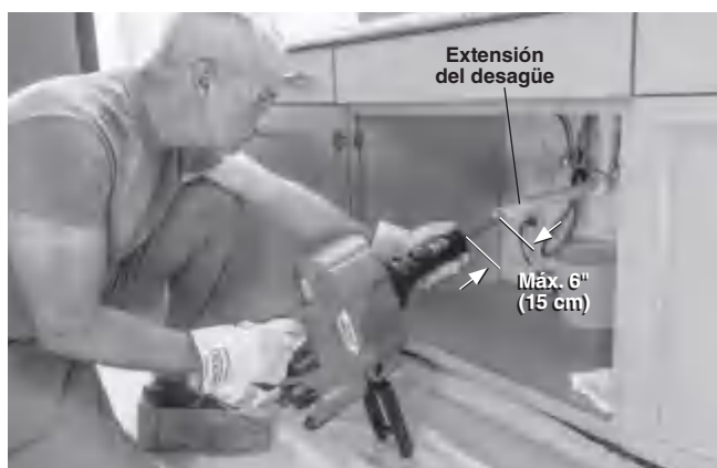
Figura 6 – Ejemplo de la extensión del desagüe para que quede a menos de 6 pulgadas (15 cm) de la unidad AUTOFEED
