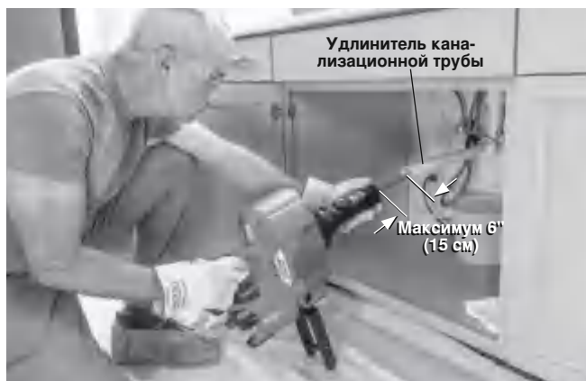
Рисунок 6 – Пример удлинения стока до расстояния 6" (15 см) от устройства автоподачи.
