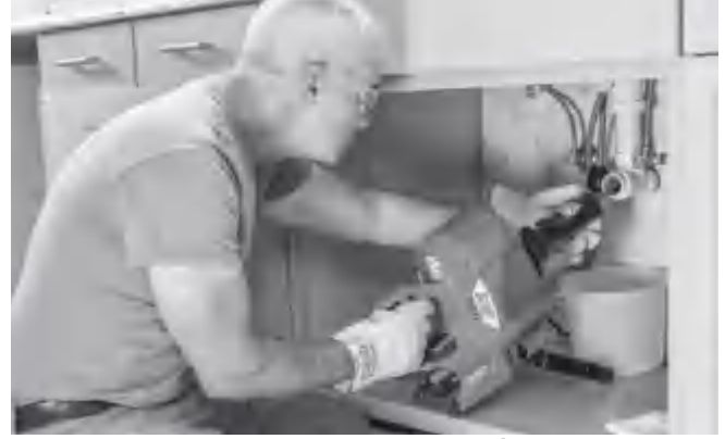
Şekil 13 – Kablonun AUTOFEED Ünitesi İle Beslenmesi
