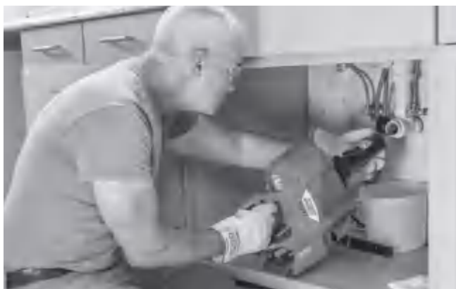
图 13 – 使用 AUTOFEED 自动进给单元推进钢索
