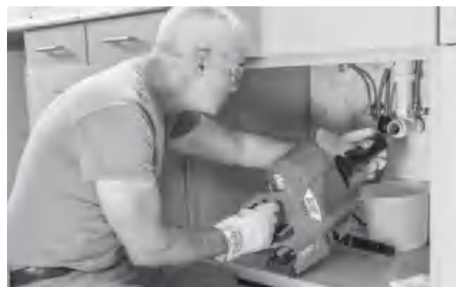
Figura 13 - Inserimento del cavo con l'unità AUTOFEED
