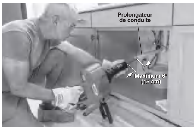
Figure 6 – Exemple de prolongation d'évacuation pour l'amener à moins de 6" (15 cm) du système AUTOFEED
