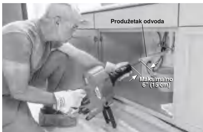
Slika 6 – Primjer produžetka odvoda na udaljenost manju od 6" (15 cm) od jedinice
