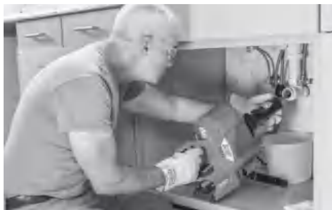
Slika 13 – Sprovođenje sajle sa AUTOFEED jedinicom
