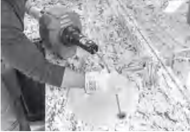
Şekil 14 – Kablonun Manuel Beslenmesi
