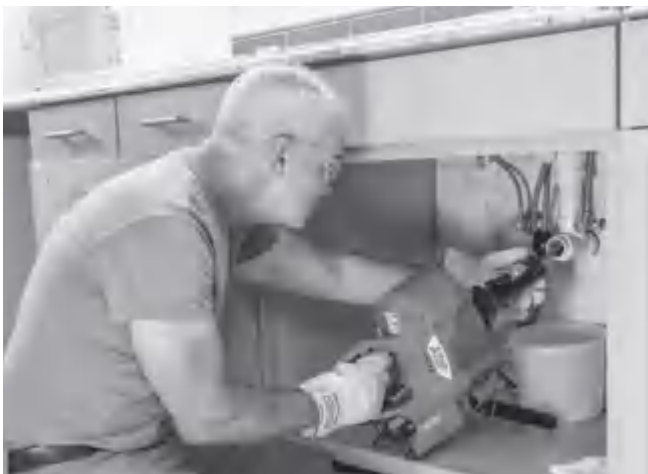
Abbildung 13 – Vorwärtsschieben der Spirale mit AUTOFEED
