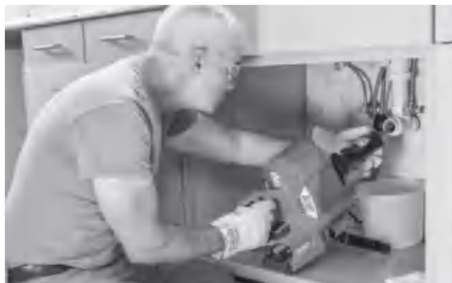
Obrázek 13 – Podávání kabelu pomocí jednotky AUTOPOSUVU
