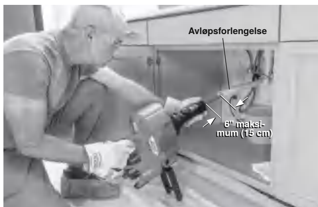
Figur 6 – Eksempel på forlengelse av avløpet så det er innenfor 6" (15 cm) for AUTOFEED-enheten
