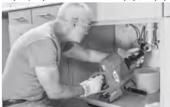
Slika 13 – Uvlačenje sajle kroz s jedinicom AUTOFEED
