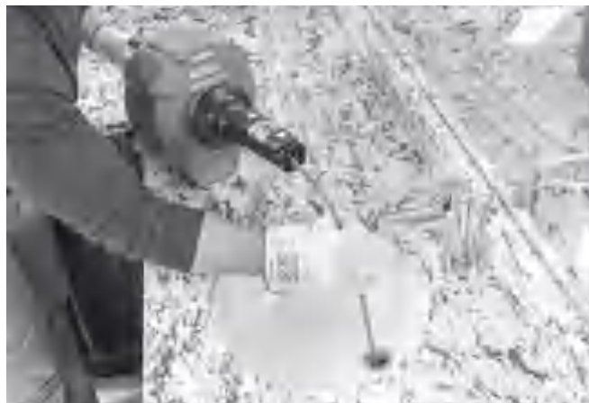
Figur 14 – Manuell frammatning av spiralen
