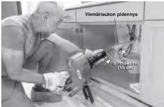
Kuva 6 - Esimerkki viemäriaukon pidentämisestä yli 6" (15 cm) päähän AUTOFEED -yksiköstä
