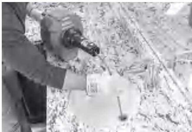
Рисунок 14 – Подача троса вручную
