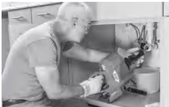
Рисунок 13 – Подача спирали с помощью устройства автоподдачи
