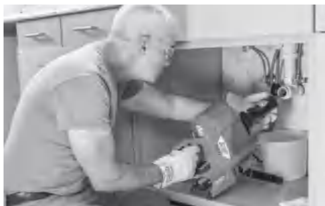
Slika 13 – Podajanje spirale skozi enoto AUTOFEED
