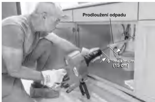
Obrázek 6 – Příklad prodloužení odpadu na vzdálenost do 6" (15 cm) od jednotky AUTOPOSUVU
