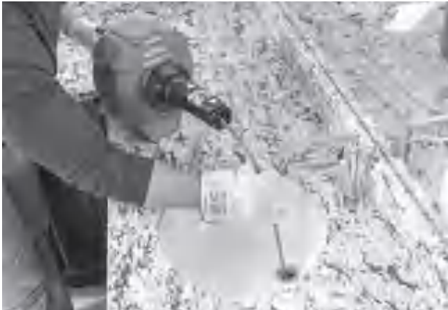
図 14 - 手動でのケーブルの送り出し
