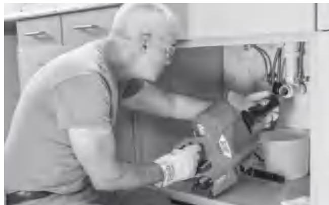
Figura 13 – Empurrar o cabo com unidade AUTOFEED
