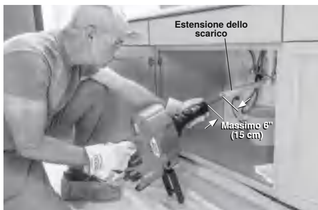
Figura 6 - Esempio di estensione dello scarico fino ad un massimo di 6 pollici (15 cm) dall'unità AUTOFEED
