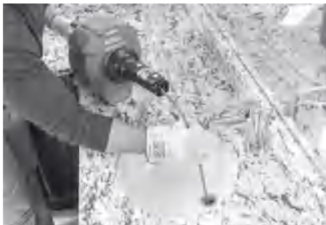
Figura 14 – Avançar o cabo manualmente
