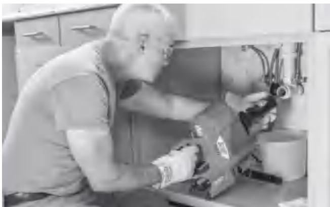
Фигура 13 – Подаване на кабел с AUTOFEED блока
