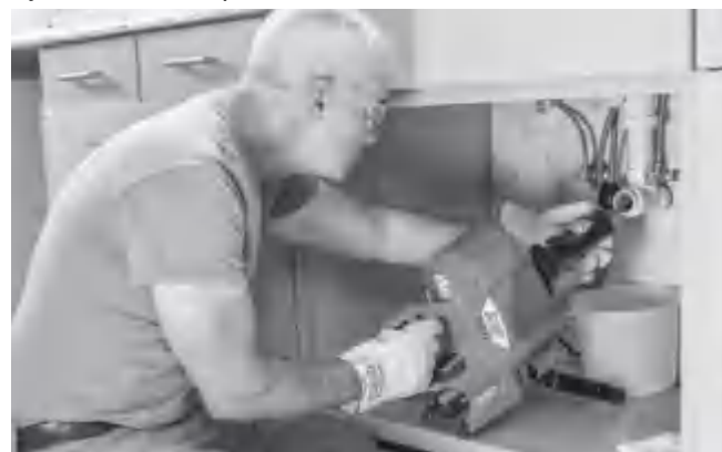
Obrázok 13 – Zavádzanie kábla pomocou jednotky autoposuvu AUTOFEED
