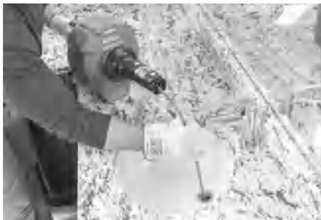
Figura 14 – Avansarea manuală a cablului
