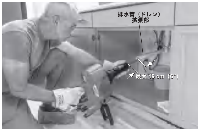
図 6 – AUTOFEED ユニットの 15 cm (6") 以内の範囲にできるようにする排水管延長の例
