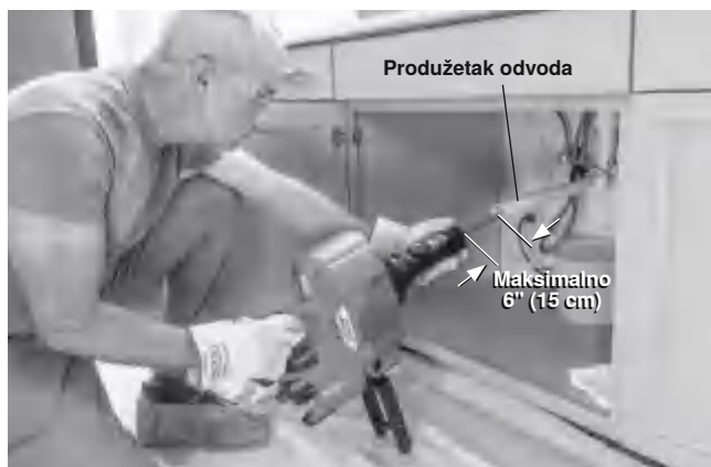
Slika 6 – Primer produženja odvoda do daljine od 6" (15 cm) od AUTOFEED jedinice
